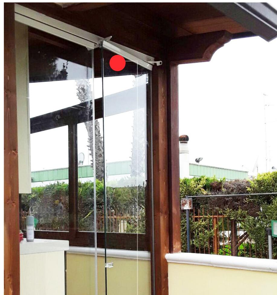
В данной конфигурации предусмотрена позиция для проветривания, которая фиксирует дверь в приоткрытом состоянии, а также дополнительно позволяет раздвинуть остальные панели, оставляя зазор между ними для более основательного проветривания помещения.
